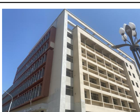
图 2 老年护理院综合楼
