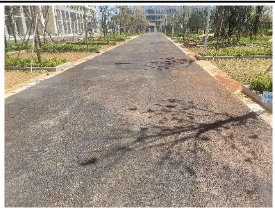
图 3 场内道路现状（一）
