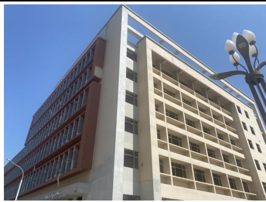
图 2 老年护理院综合楼
